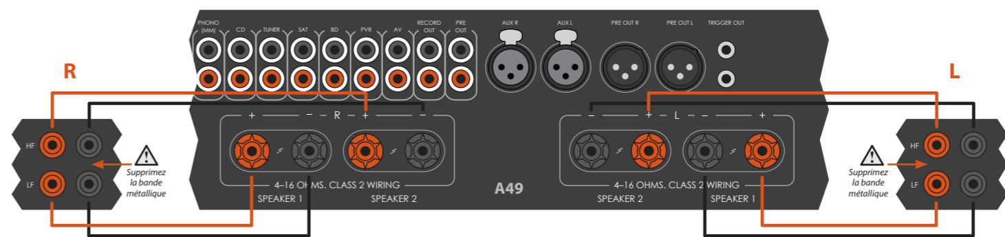
Un A49 branché à deux ensembles de haut-parleurs à l'aide d'un double câblage.
